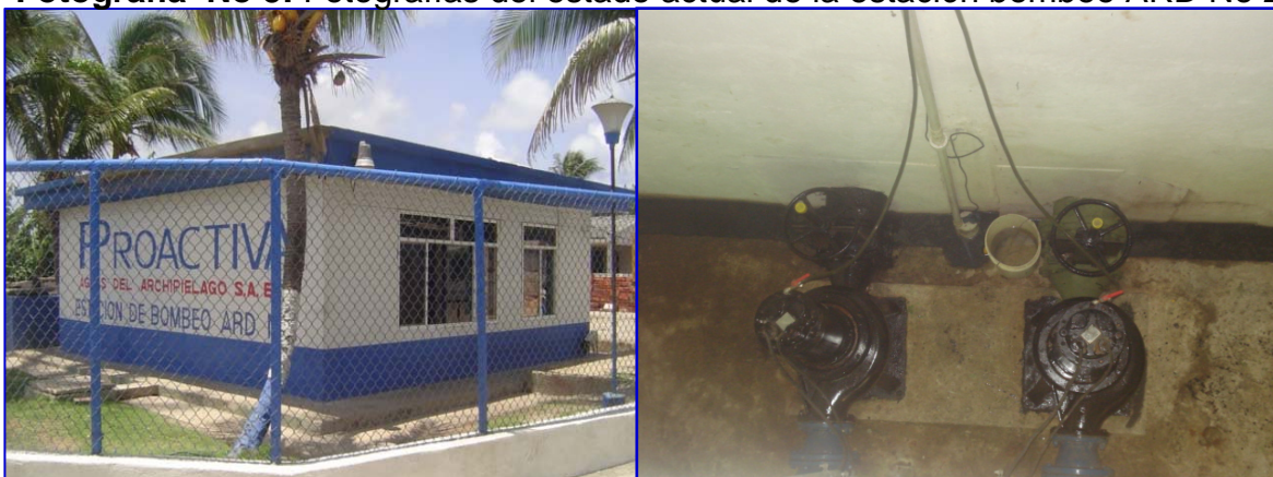
Fotografía No 5: Fotografías del estado actual de la estación bombeo ARD No 2
