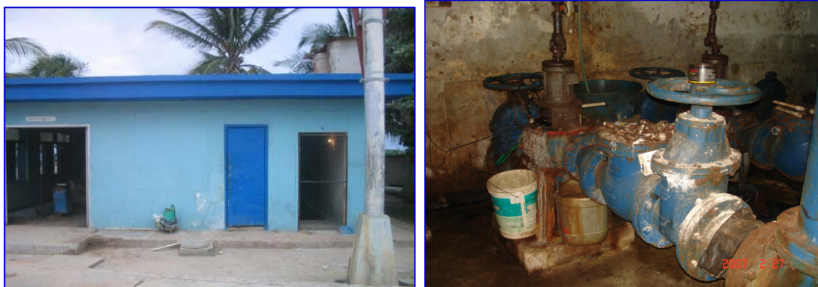
Fotografía No 4: Fotografías del estado inicial estación bombeo de ARD No 2
